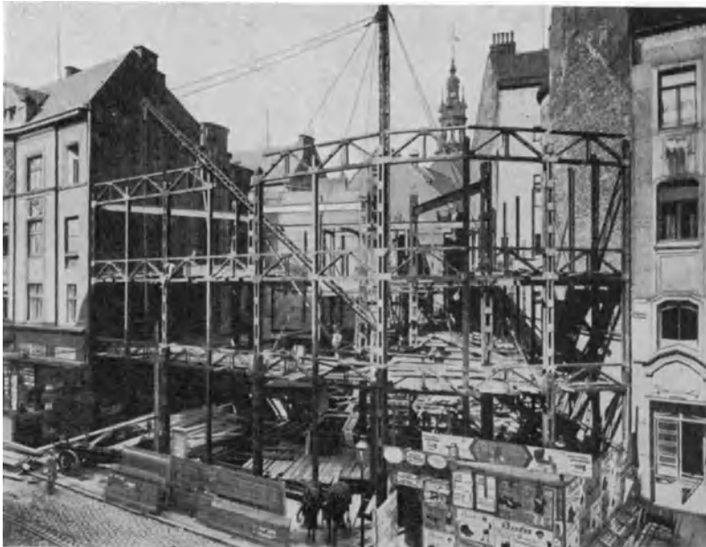
Abb. 7. Kaufhaus „Textilia“ in Mähr. Ostrau. Montagebild. Ausführung: Eisenwerk Witkowitz.
