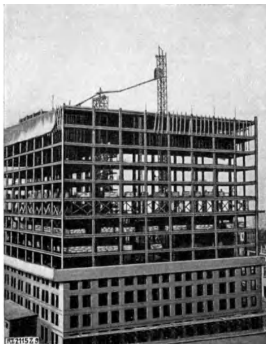
Abb. 338. Ausführung eines Stahlhochhauses in Amerika. (Nach Griesel, H. Dr.: Z. V. d. I. 1929, S. 372.)
