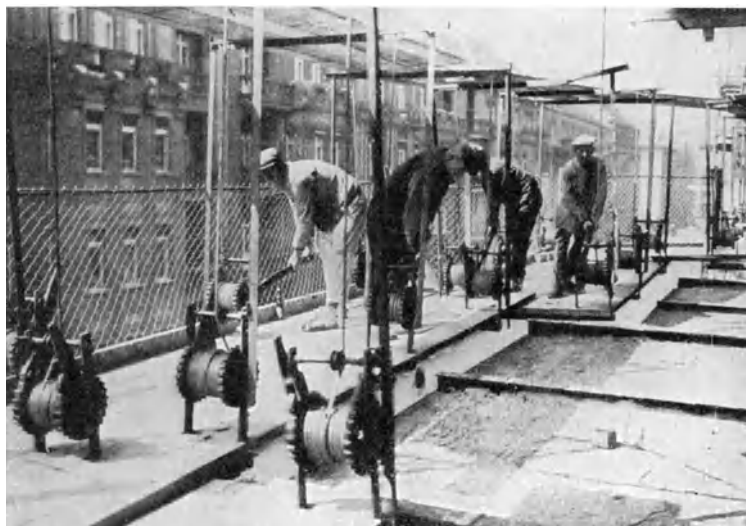
Abb. 315. Torkret-Schnellbaurüstung D.R.P. Handhaben der Winden.
