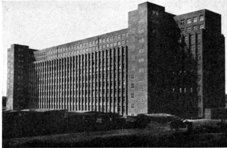
Abb. 1. Schaltwerk-Hochhaus der Siemens-Schuckertwerke in Berlin-Siemensstadt. Ansicht von Nordosten. Arch.: Dir. Hans Hertlein, Berlin (Hertlein, H.: „Der Industriebau“ 1929).
