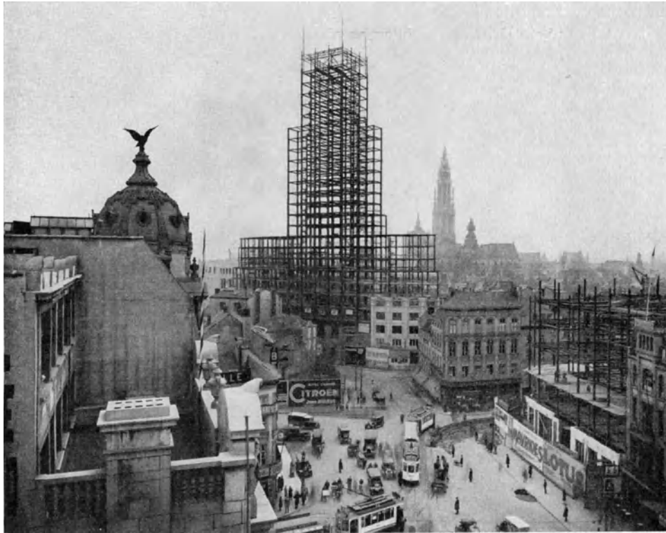
Abb. 452. Hochhaus der Allgem. Bankvereinigung in Antwerpen. Ansicht des fertigen Stahlskelettes. Ausführung: DEMAG Aktienges. Duisburg.
