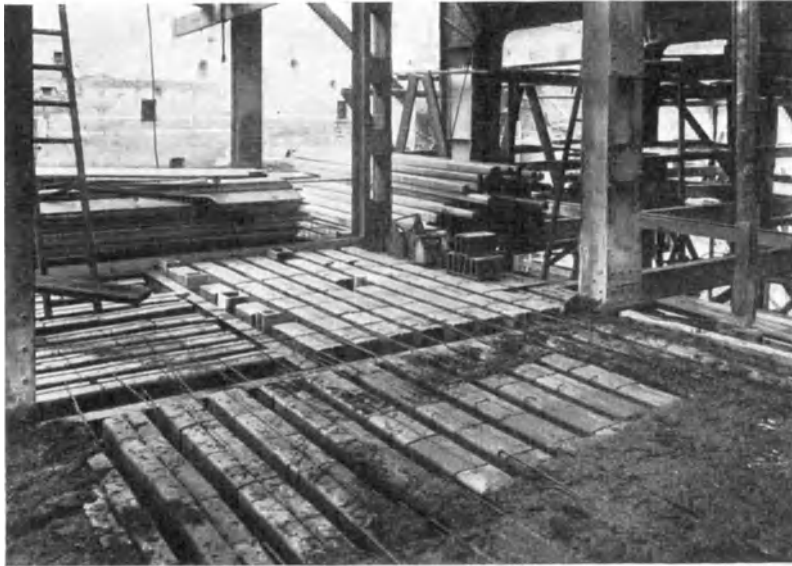
Abb. 335. Hochhaus Suschitzky Prag. Herstellung der Hohlsteindecken.
