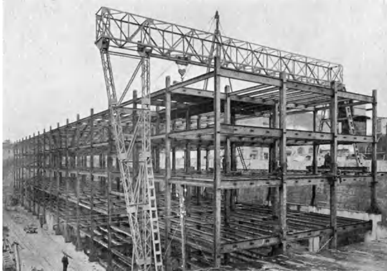
Abb. 318. Postlagergebäude Stettin. Montage mittels Portalkrans. Ausführung: J. Gollnow & Sohn, Stettin.
