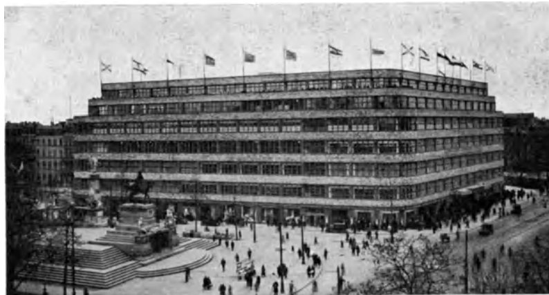
Abb. 2. Warenhaus Wertheim in Breslau. Arch.: Prof. Dernburg. Ausführung des Stahlskelettes: Carlshütte A. G., Waldenburg-Altwasser i. Schl.
