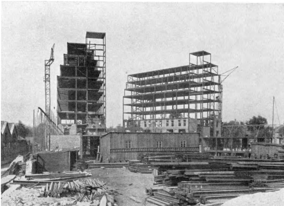
Abb. 435. Verwaltungsgebäude der Sozialversicherung, Paris. Montage der beiden Flügelbauten. Ausführung: Gutehoffnungshütte Oberhausen und Gesellschaft Harkort, Duisburg.
