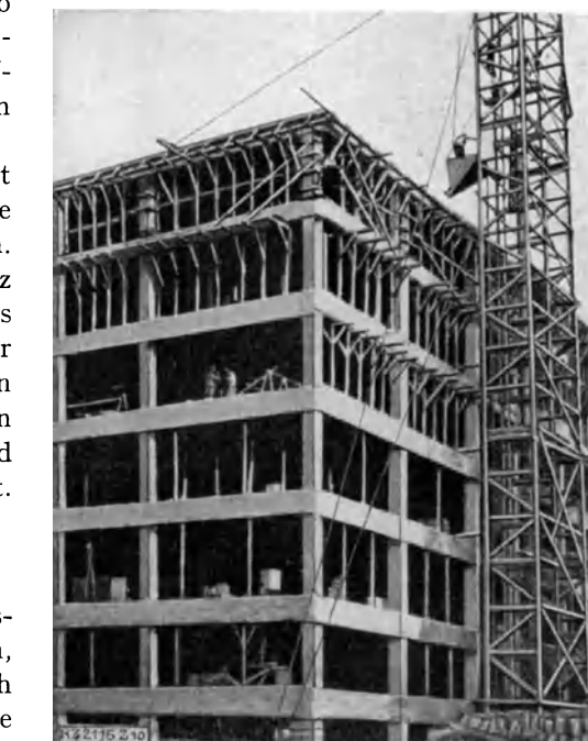
Abb. 339. Ausführung eines Eisenbeton-Hochbaues in Amerika. (Nach Griesel, H. Dr.: Z. V. d. I. 1929, S. 372.)
