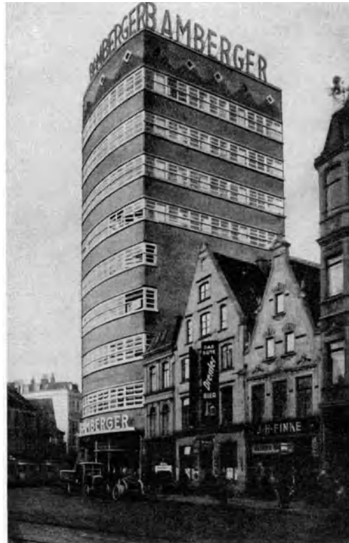
Abb. 436. Geschäftshaus Bamberger, Bremen. Ausführung: Gutehoffnungshütte, Oberhausen.
