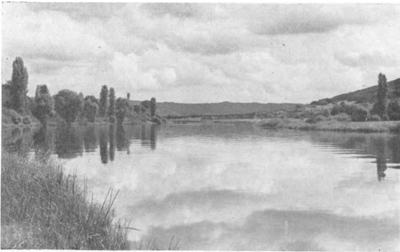
Abb. 3. Beispiel einer mustergültigen Kanalisierung 1 . (Der kanalisierte Main bei Dorfprozelten.) Schöner Uferwuchs, keine Verunstaltung der Landschaft.
