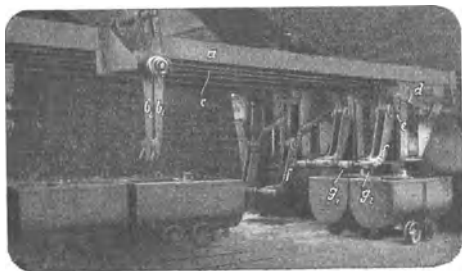
Abb. 357. Aufschiebevorrichtung der Maschinenfabrik Hasenclever A.-G.
