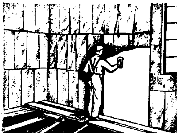
Рис. 222. Отделка изоляционными панелями под штукатурку.
