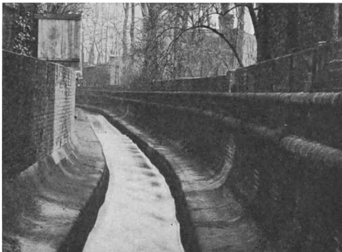
Abb. 88. Dampfheizwerk Barmen. Im Mühlgrabenbett verlegte Dampffernleitung.
