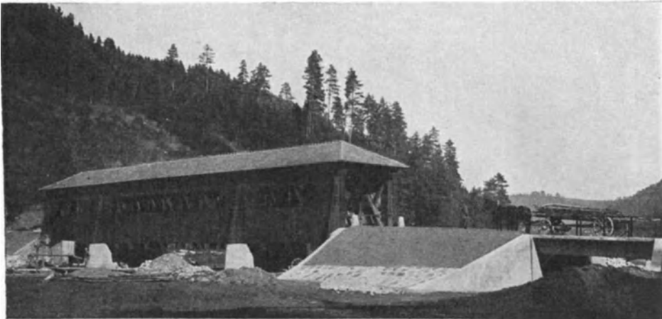
Abb. 459. Neckarbrücke bei Thalhausen nach Vollendung.
