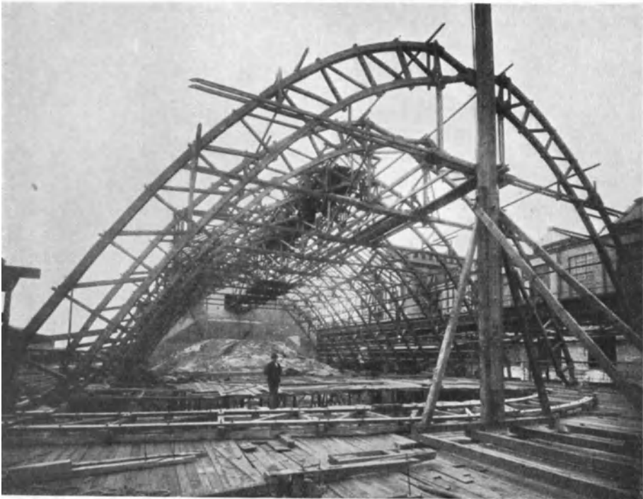
Abb. 279. Aufstellung der Binder des Baues Op. 95.
