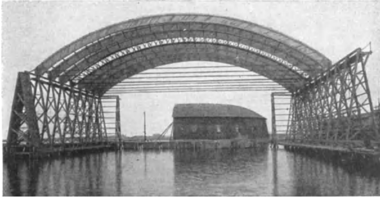
Abb. 213. Hafenhalle II in Warnemünde. (Ausführung: Carl Tuschcherer A.-G., Breslau.)
