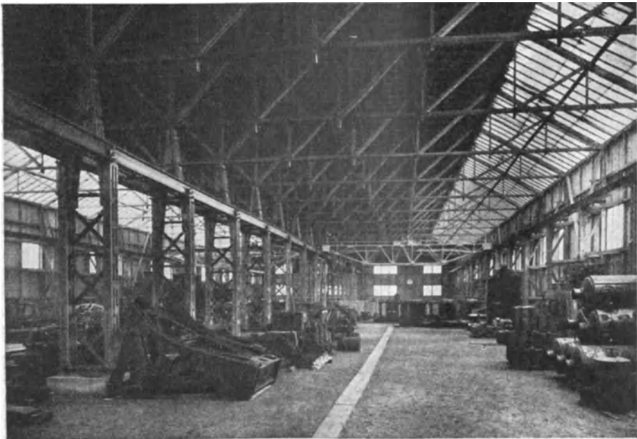
Abb. 306. Innenansicht der fertigen Lagerhalle der Maschinenfabrik Augsburg-Nürnberg A.-G. in Nürnberg. Handbibliothek IV, 2.
