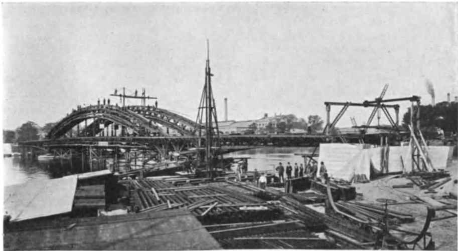
Abb. 508. Überbau der Treskowbrücke kurz vor Vollendung. Vernietung der Bogen von Nietrüstungen aus.
