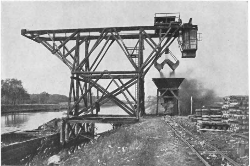
Abb. 380. Müllabladegerüst nach Vollendung, jedoch noch ohne eingebautem Maschinenhaus.
