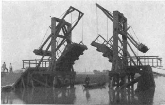
Abb. 424. Fertige Brücke in geöffnetem Zustande (ohne Hinterfüllung).
