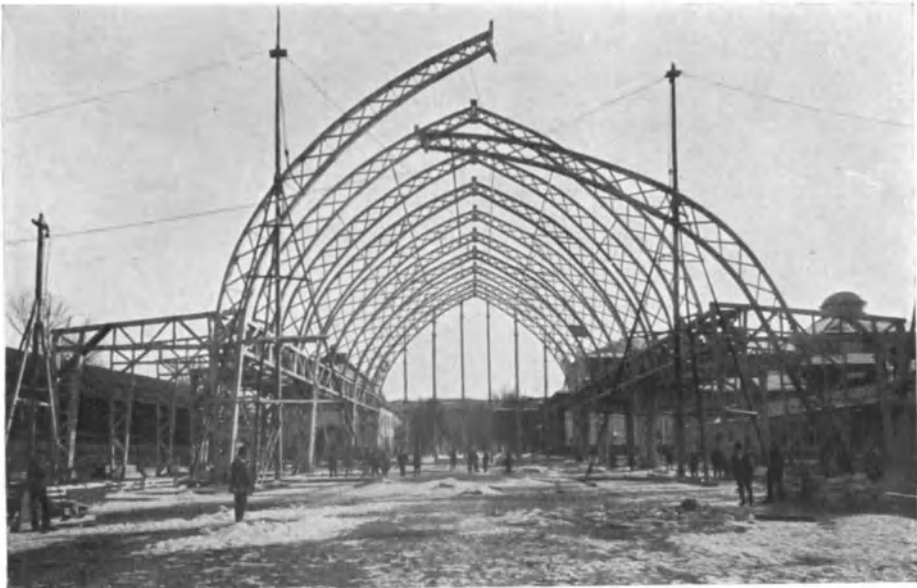
Abb. 321. Halle für Luftfahrt während der Aufstellung.
