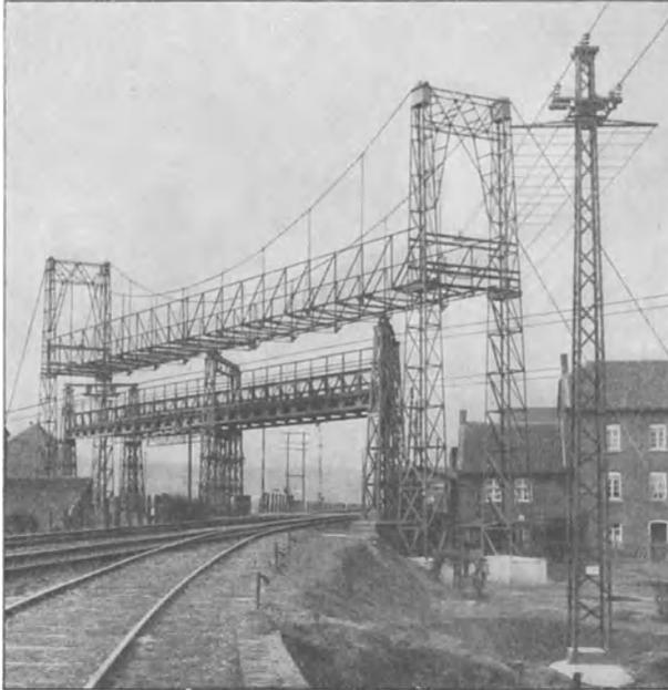
Fig. 282. Kreuzung der Staatsbahn Köln – Aachen und der Seilbahn des Eschweiler Bergwerksvereins mit freistehender Schutzbrücke aus Profileisen; die Leiter sind auf der Brücke montiert.
