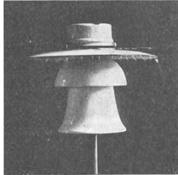
Fig. 198. Hochspannungsisolator mit Metallschirm im Regen unter Spannung.
