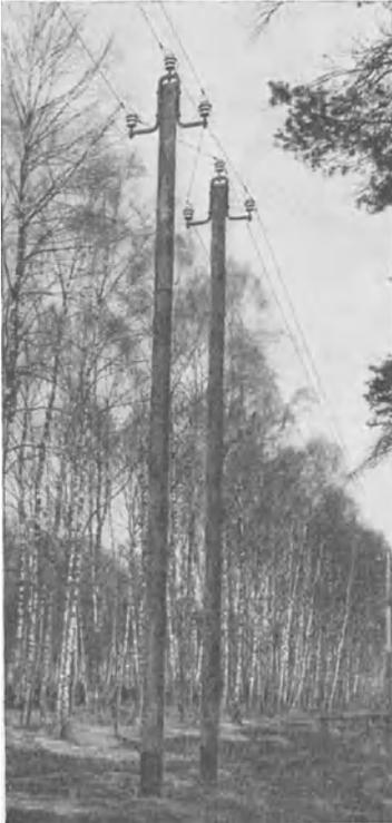
Fig. 276. Verdrillungspunkt einer 15 000 Volt-Drehstromleitung auf Holzmasten mit Lyratraversen. (Sicherheitsbügel nach Fig. 267.)
