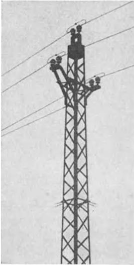
Fig. 260. Vogelschutz-Doppeltraverse am Gittermast.
