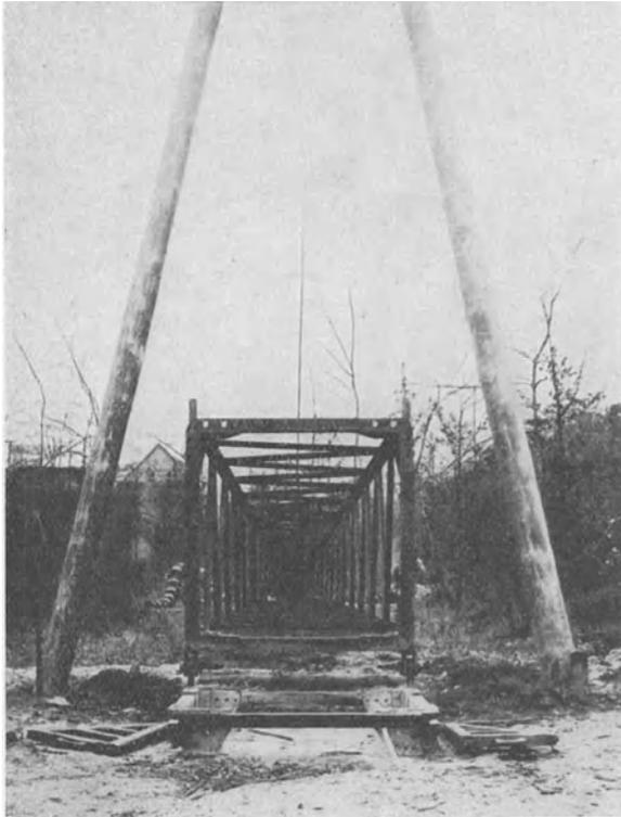
Fig. 173. 110000 Volt Fernleitung des Murgwerkes. Streckengitterturm vor dem Aufrichten (Fundament fertig, Blick auf den Mast, B.B.C.).
