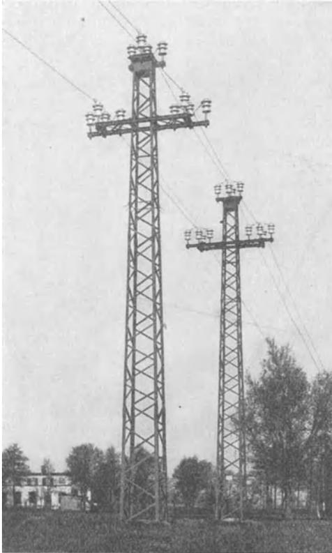
Fig. 286. Bruchsichere Straßenkreuzung einer 70000 Volt Drehstromleitung (Oberrheinische Kraftwerke, Mülhausen i. Els.).
