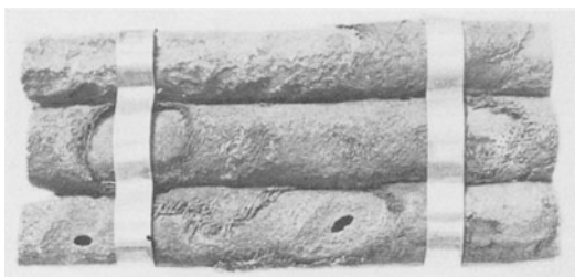
Abb. 1. Korrosion an Rohrleitungen durch Streuströme. (Nach WIEDERHOLT.)
