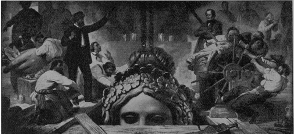
Fig. 7. Heraufziehen des Kopfes der Bavaria aus der Grube.
