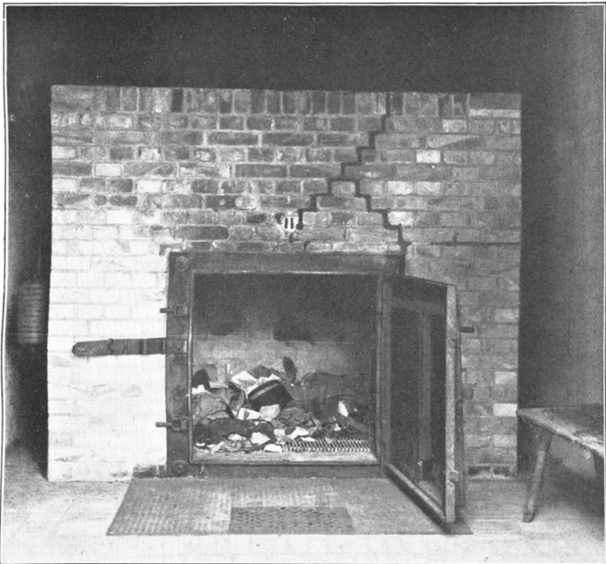
Verbrennungsofen in einer Desinfektionsanstalt.
