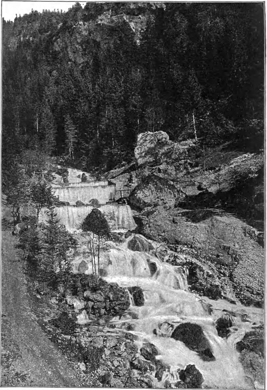
Fig. 278. Wasserfall bei Zinsbrud, welcher jetzt zum Betriebe des dortigen Elektrizitätswerkes dient.
