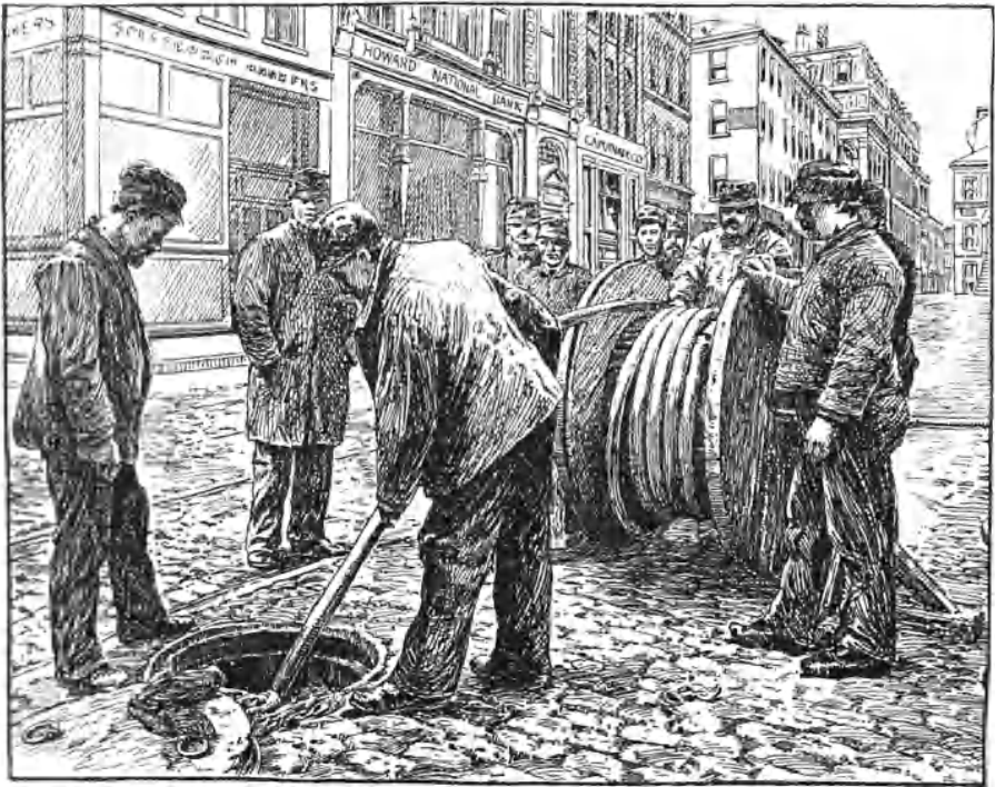
Fig. 689. Einlassen des Kabels in das Rohr.
