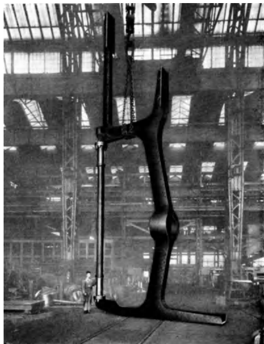
Abb. 184. Hinterstegen. Gewicht des Stahlgußstücks 21 000 kg. Krupp.
