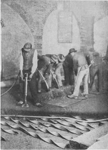
Abb. 7. Schwere Betonstampfer bei der Arbeit.
