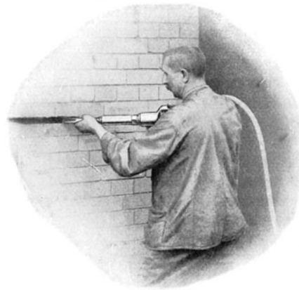
Abb. 6. Preßlufthammer bei der Herstellung von Rillen und Kanälen im Mauerwerk.
