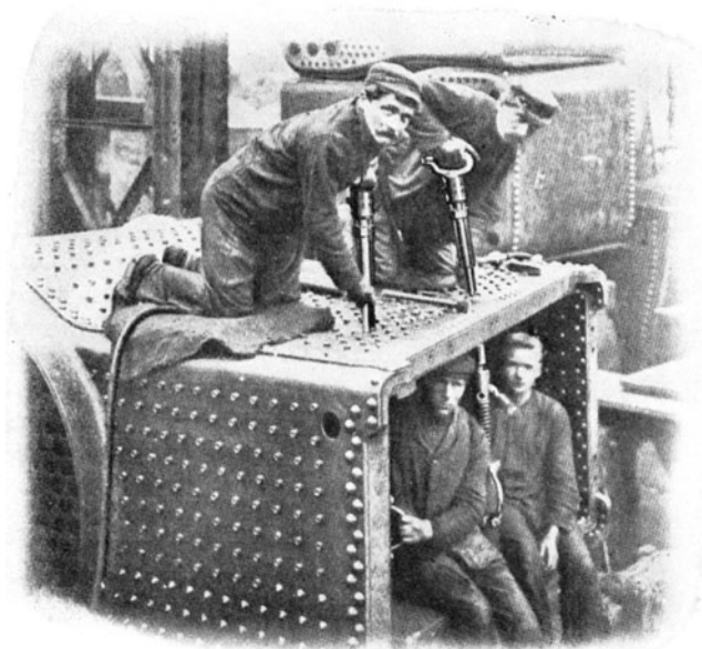
Abb. 5. Stehbolzenhämmer bei der Herstellung einer Feuerbuche.
