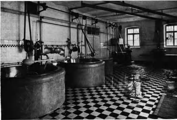
Abb. 4. Käsekessel mit Leiter-Rührwerk
