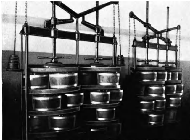
Abb. 8. Doppelte zweihebelige Käsepresse für Gouda-Käse
