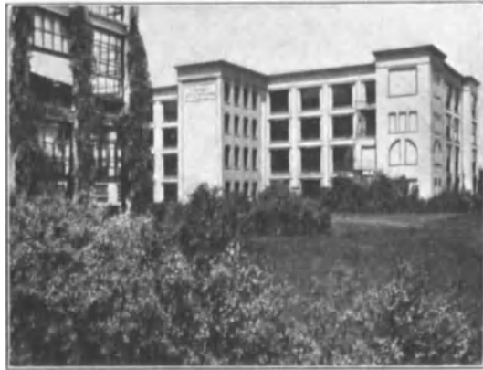
Fig. 39. Ein Fabrikgebäude der National-Registerkassen-Gesellschaft in Dayton.
