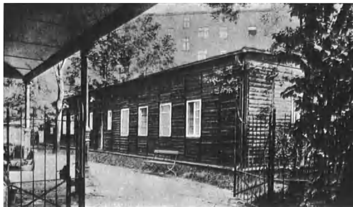
Abb. 6. Baracke der Hebammenschule 1926.
