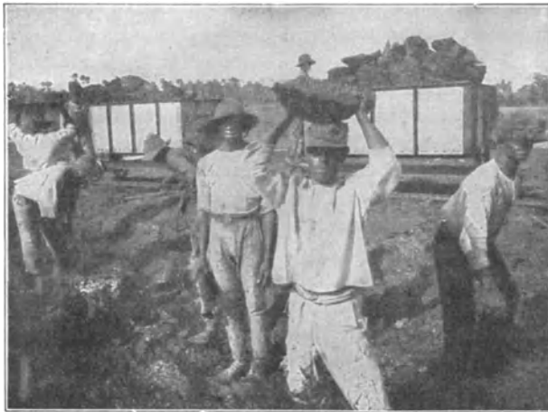
Verladung des gewonnenen Asphalts in Feldbahnwagen.
