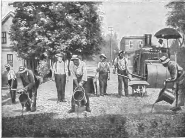
Herstellen der Binderschicht nach der Durchtränkungsmethode.
