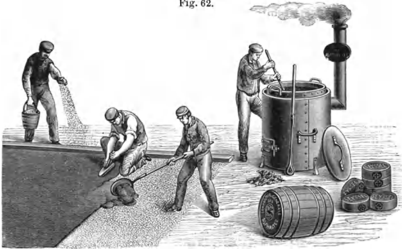
Asphaltierer bei der Arbeit.
