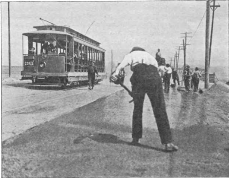
Absanden der asphaltierten Oberfläche.
