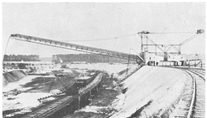
Abb. 18. Abraumförderbrücke ohne Stütze
