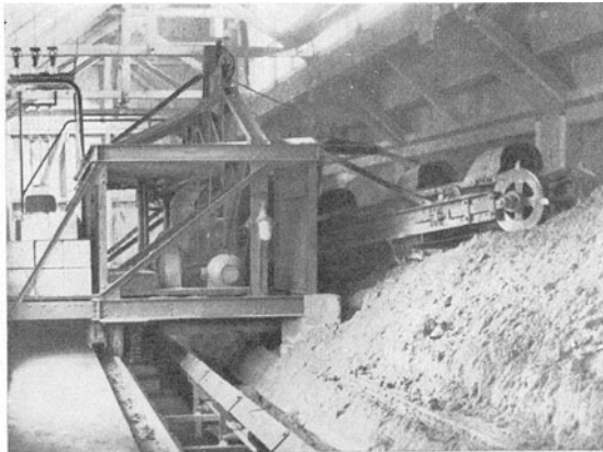
Abb. 4. Als Bagger ausgebildetes Aufgabegerät
