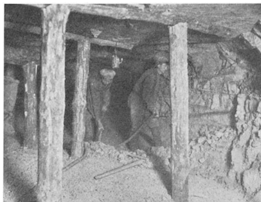
Abb. 2. Mathildegrube, Erzpfeiler in Betrieb
