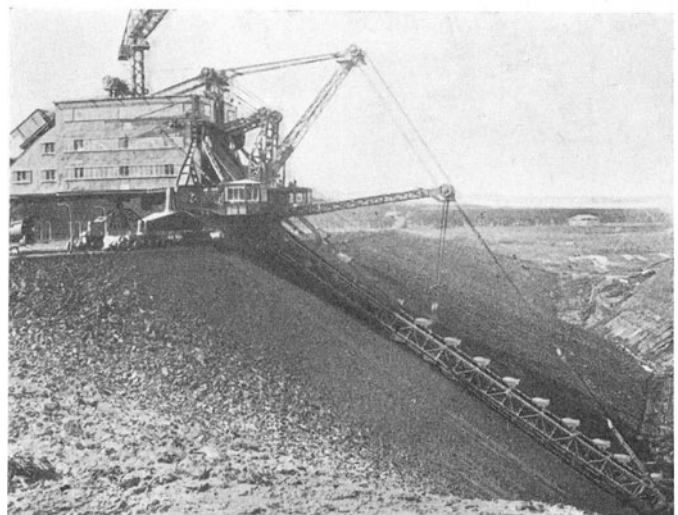
Abb. 12. Kohlenbagger für 40m Schnitttiefe
