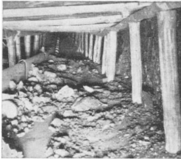
Abb. 6. Stauscheibenförderer mit Winkelrinne
