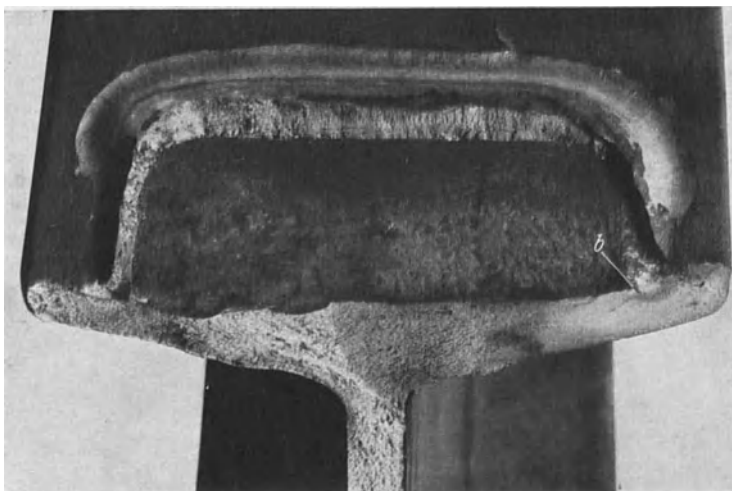
Abb. 37. Bruchstelle des Trägers 1.V2 der Reihe 1. Stirnkehlnaht nach Abb. 31; a = 4,2 \text{ mm} ; \alpha_A = 22^\circ .
