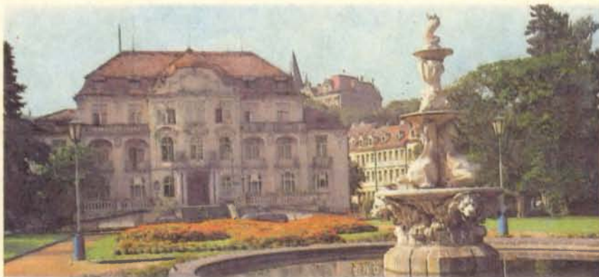
Теплице. Санаторий «Каменне-Лазне».
