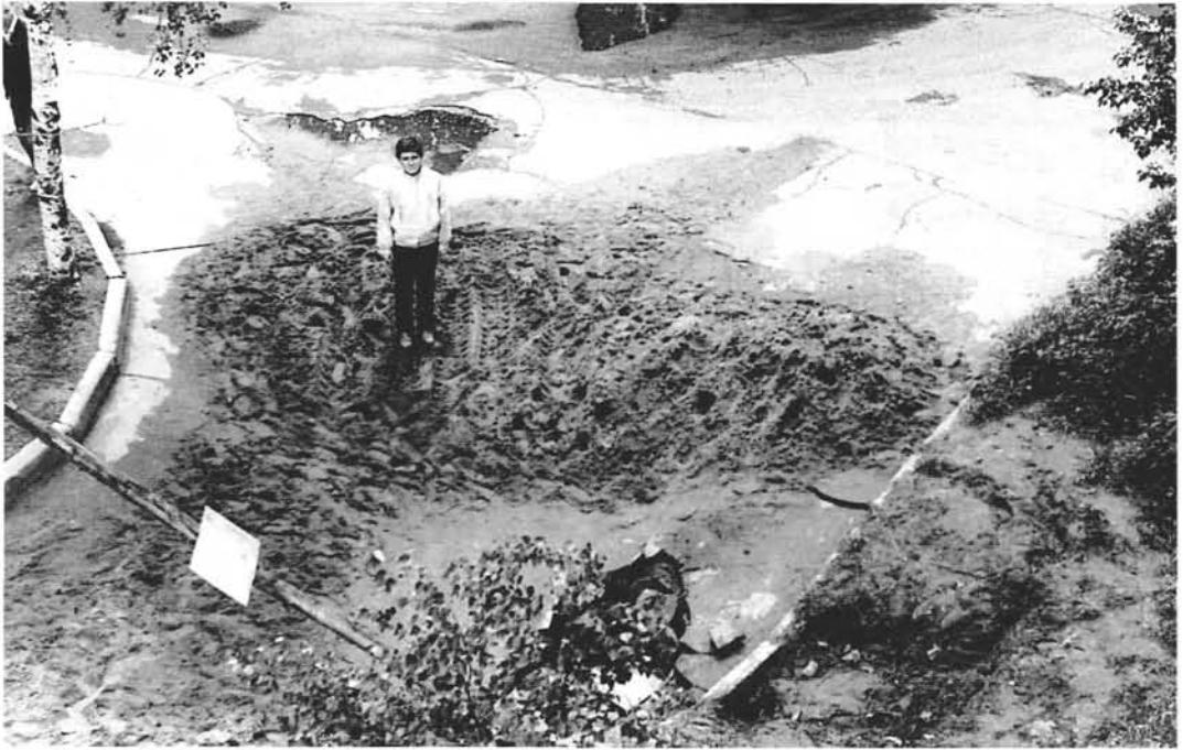
Рис 7 9 Провальная воронка на ул Маршала Тухачевского (фото Аникеева А В июль 1987)
