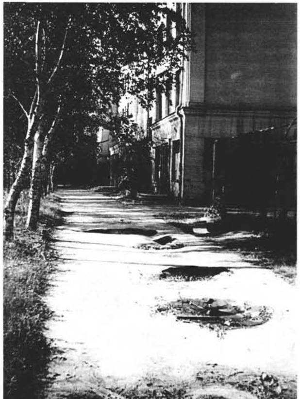
Рис 7 11 Суффозионные провалы над теплотрассой (фото Хоменко В П )
