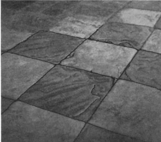
Abb. 42. Der gleichmäßig zusammengesetzte Marmor (hell) nützt sich auch gleichmäßig ab. Die dunklen Fliesen dagegen nützen sich recht unregelmäßig ab; sie bestehen aus Grünschiefer, in dem der leichter abnutzbare Chlorit und die widerstandsfähigeren Mineralien Hornblende und Epidot ungleichmäßig verteilt sind. Pfarrkirche von Völkermarkt, Kärnten. Eigenaufnahme 1932.
