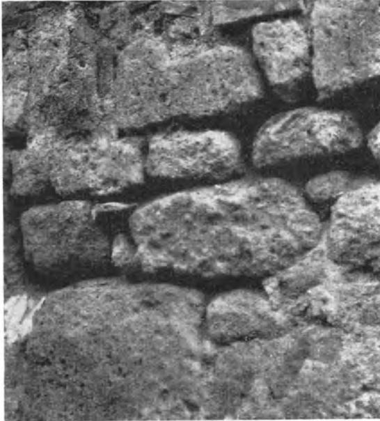
Abb. 34. Leicht verwitternde Gesteine verlieren rasch ihre scharfen Kanten; auch die Ecken runden sich ab. Basalttuff in einer Böschungsmauer; Orvieto, Via Postierla. Eigenaufnahme 1930.
