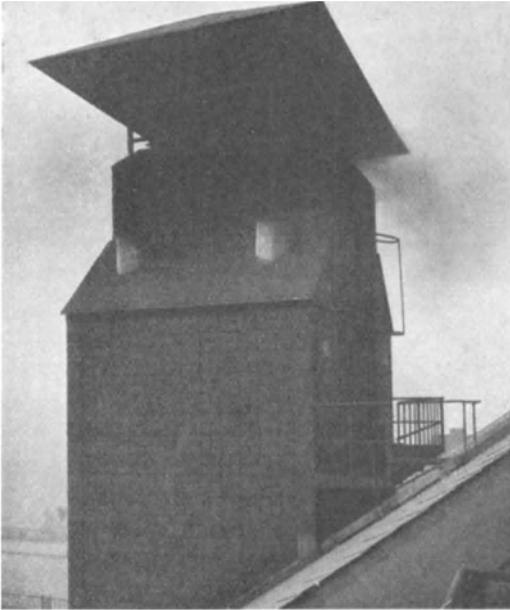
Abb. 72 a. Schlot-Elektrofilter, eingeschaltet.
