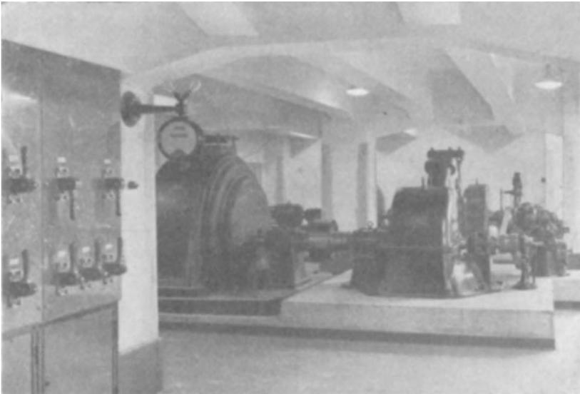
Abb. 81. Hilfskraftanlage des Walchenseewerkes. 2 Drehstromerzeuger von 350 bzw. 750 kVA, 220/380 Volt und 50 Perioden, direkt gekuppelt mit 2 Peltonturbinen von 450 bzw. 850 PS-Leistung.
