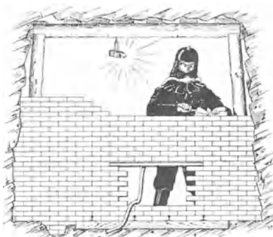
Abb. 675. Herstellung eines Mauerdamms mit Mannloch unter Verwendung eines Druckschlauch-Atmungsgerätes.
