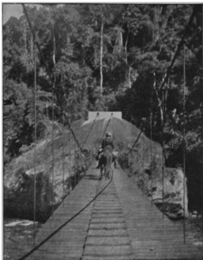
LA PUENTE PERUANA
