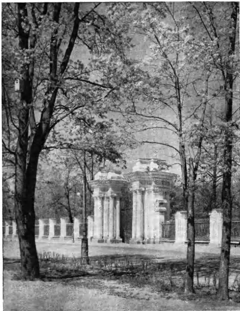
Главный вход в Верхний сад. Архитектура В. Растрелли. Середина XVIII в.
