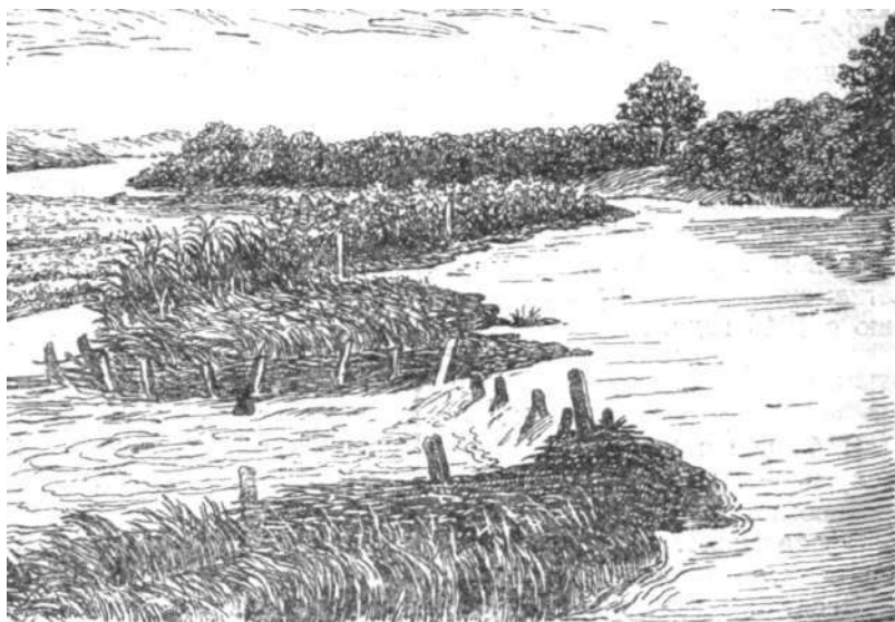
Рис. 45. Плохо поддающееся регулиции головное оросительное сооружение туземного типа возле Ташкента (1926).
