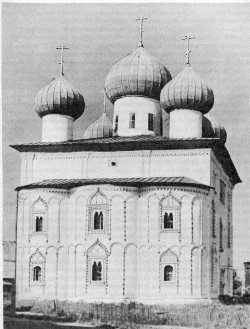
Рис. 30. Благовещенская церковь (1682—1692 гг.) в г. Каргополе, построенная из блоков доломита
