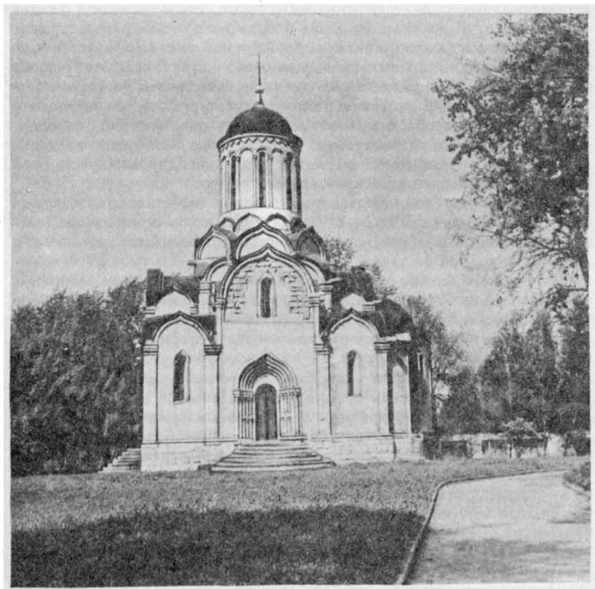
Рис. 13. Спасский собор (1420—1427 гг.) в Андрониковом монастыре сложен тесаными блоками мячковского известняка
