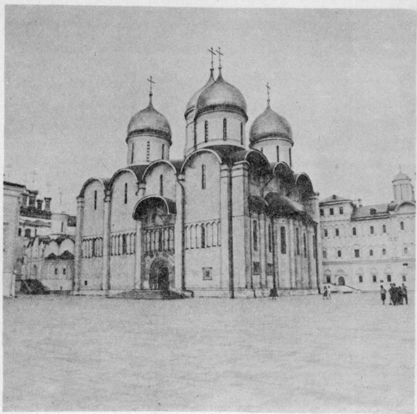
Рис. 11. Успенский собор (1475—1479 гг.) в Московском Кремле построен из тесаных блоков белого камня
