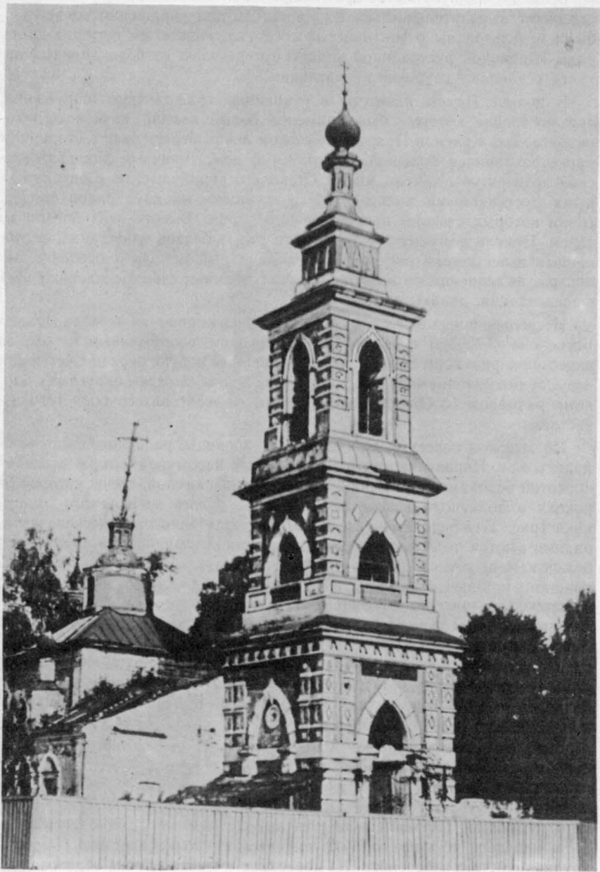
Рис. 20. Расчлененная белокаменными деталями кирпичная колокольня в с. Варварине
