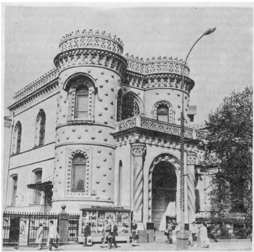
Рис. 6. Дом дружбы с народами зарубежных стран на проспекте Калинина в Москве облицован мячковским известняком. Решетки башен и балкона вырезаны из того же известняка
