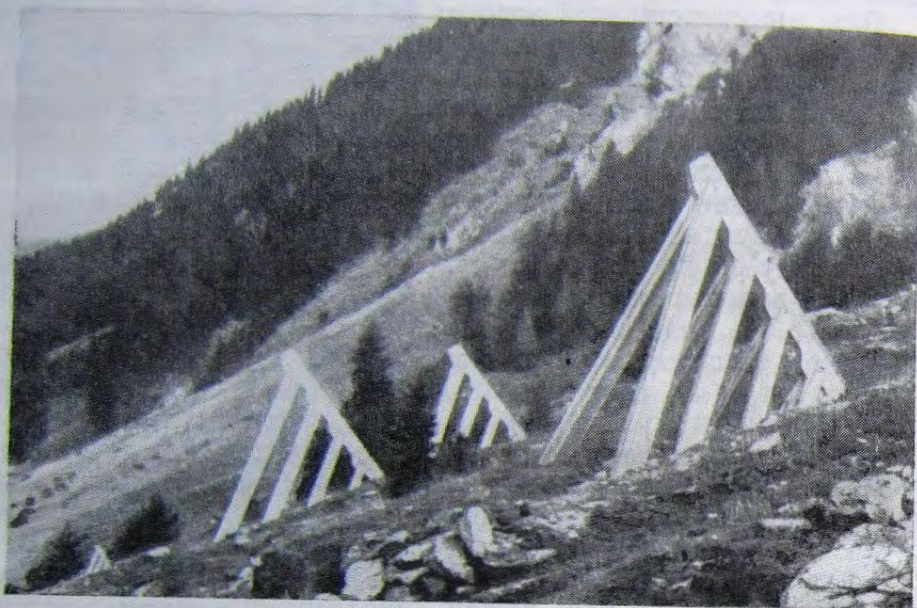
Рис. 23. Сборные лавинотормозящие клинья из предварительно напряженного железобетона (Швейцария)
