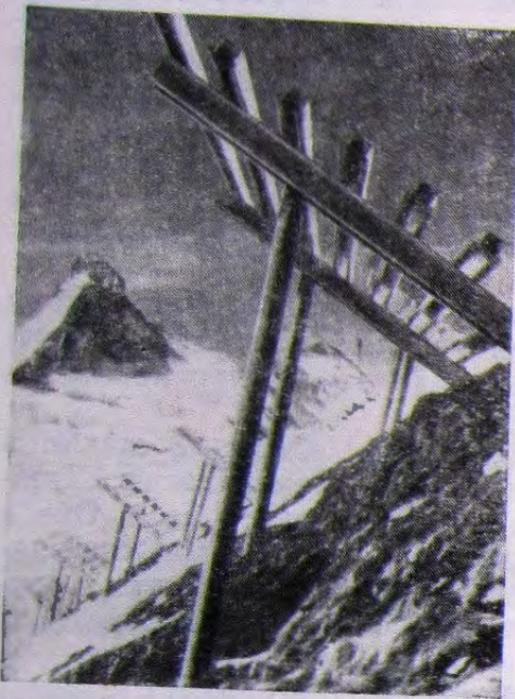
Рис. 21. Сборные металлические снегоудерживающие щиты (Швейцария)
