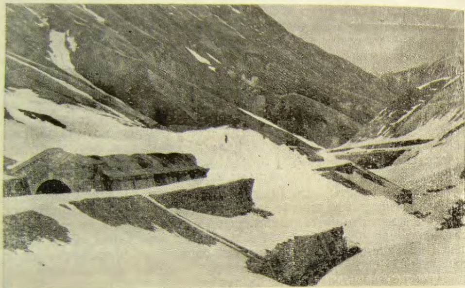
Рис. 16. Противолавинная галерея, засыпанная лавиной
