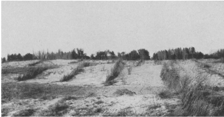
Abb. 64. Reisigzäune zur Beruhigung des Flugsandes behufs Aufforstung, Großes Alföld, Ungarn. (Phot. LEININGEN.)
