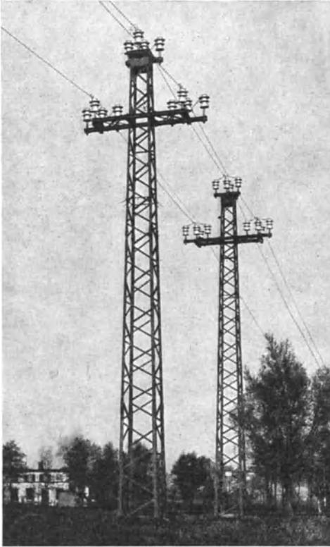
Abb. 271. Bruchsichere Straßenkreuzung einer 30-kV-Drehstromleitung.
