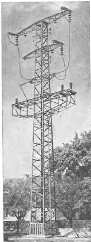
Abb. 382. Überführung eines 60 kV Dreileiter-Ölkabels in Freileitung.
