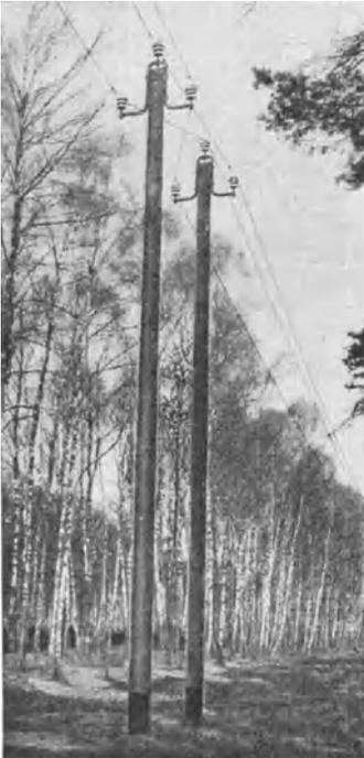
Abb. 264. Verdrillung einer 15-kV-Drehstromleitung auf Holzmasten.
