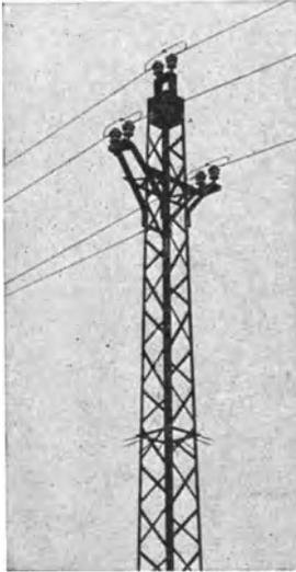
Abb. 227. Als Vogelschutz ausgebildete Isolatorenträger, Abspannmast, Sicherheitsbügel.
