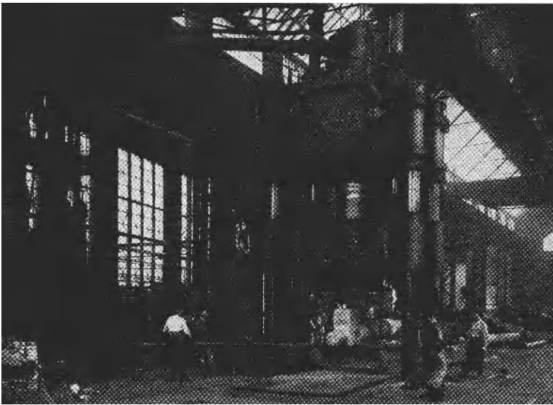
Abb. 10. Hydraulische Presse, 2000 t Preßdruck.
