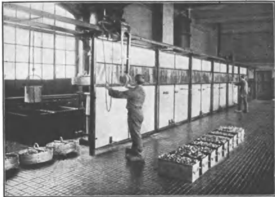
Abb. 24. Beizerei für Preßteile (TWL 350).
