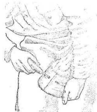
Рис. 126. Просверливание отверстия через края трещины
