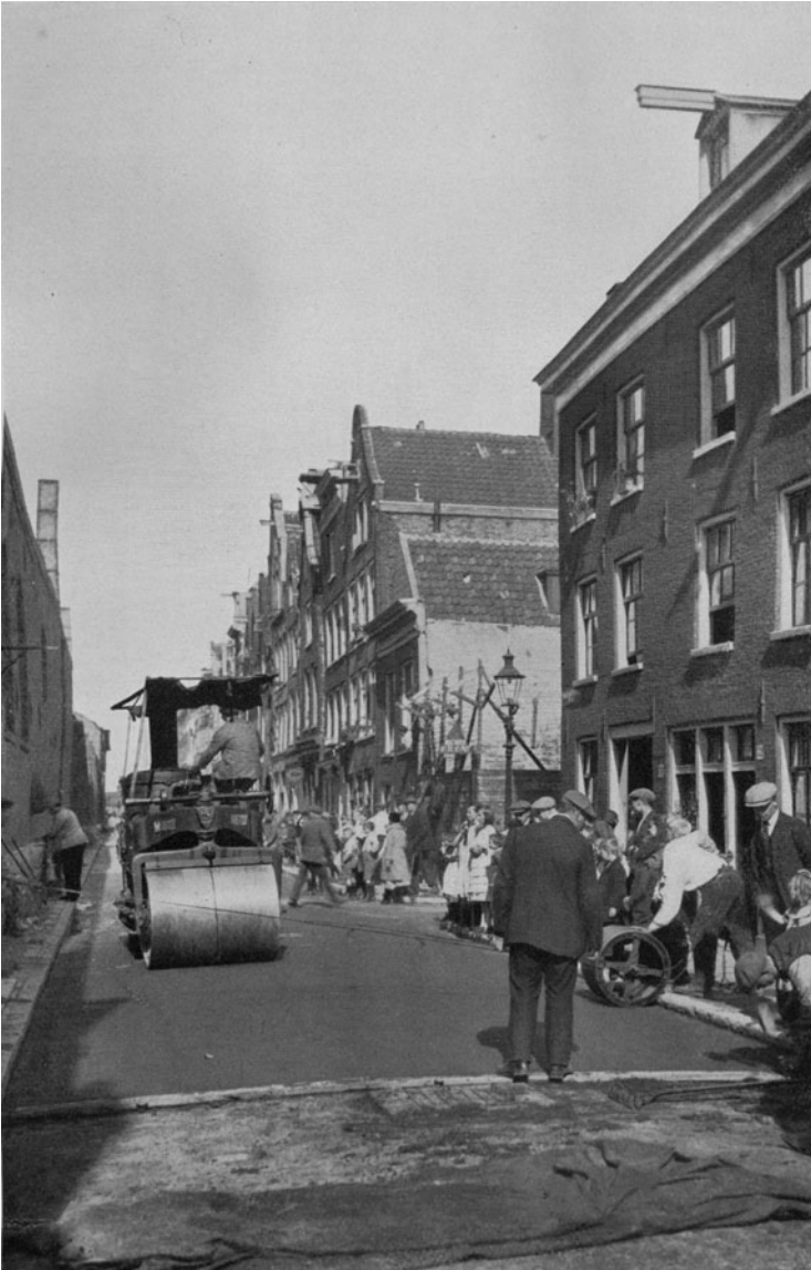
Abb. 2. Festwalzen des Sandasphalts mit einer Tandemwalze von 7 Tonnen.
