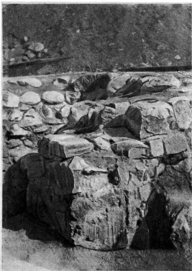
Рис. 15. Общий вид остатков каменного храма (1) и отпечатки дощатой опалубки фундаментов храма (2) на Замчище в г. Минске.
