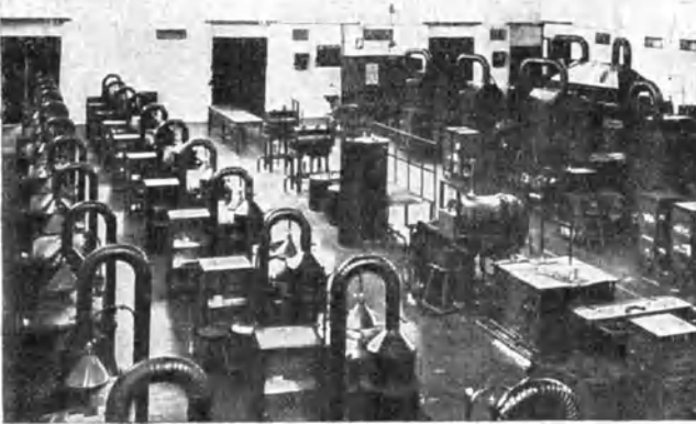
Abb. 23. Spiralbohrerhärterei (R. Stock &amp; Co.).
