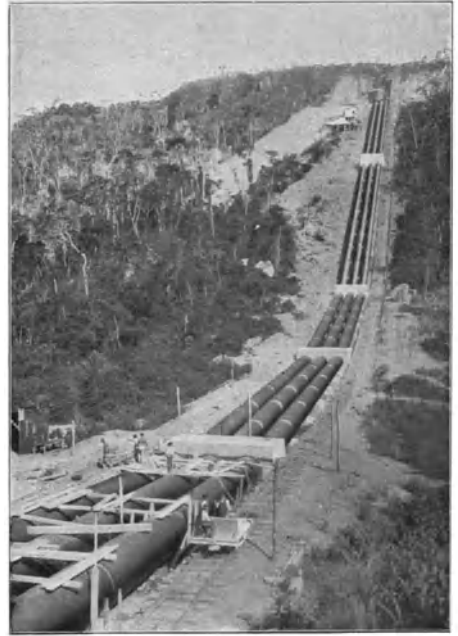
Abb. 28. Oberer Teil der Rohrfahrt der Druckleitungen für das Sorocaba-Werk.
