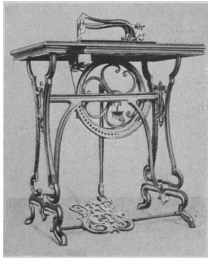
Abb. 31. Die Grover-Baker-Maschine auf Tretgestell.
