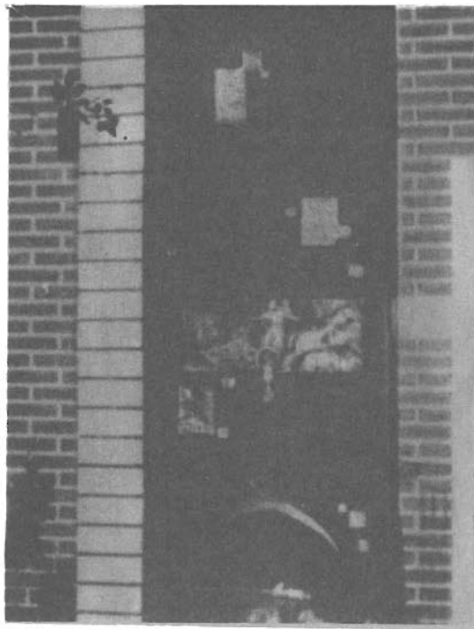
Рис. П-15-44. Общий вид стены из древесностружечной плиты, облицованной «под кирпич»
