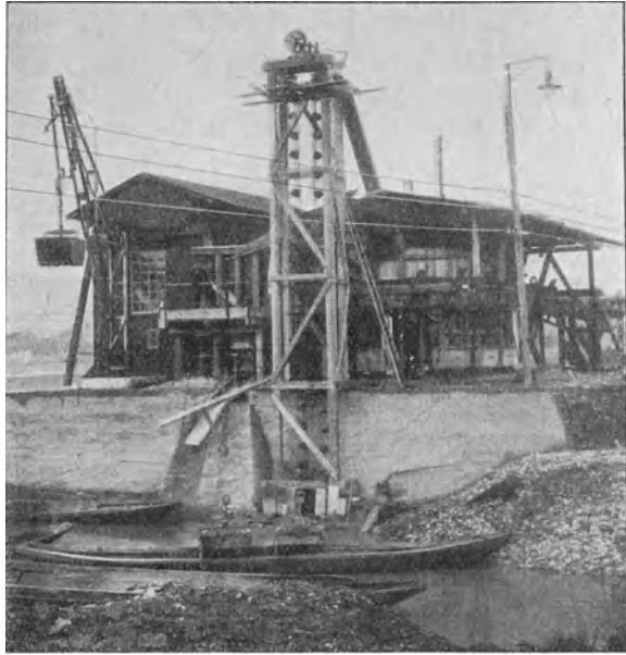
Abb. 213. Uferstation mit Beladekran und Becherwerk (Bleichert).
