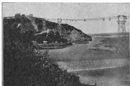
Abb. 335. Streckenbild der Orconerabahn bei Povena (Bleichert).
