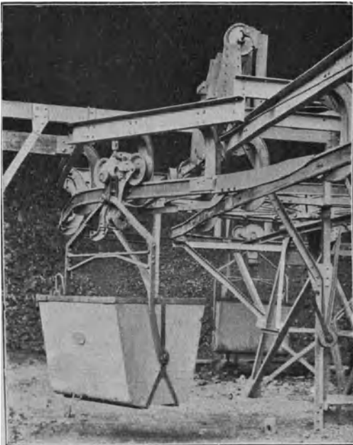
Abb. 251. Drehweiche in einer Station (Bleichert).
