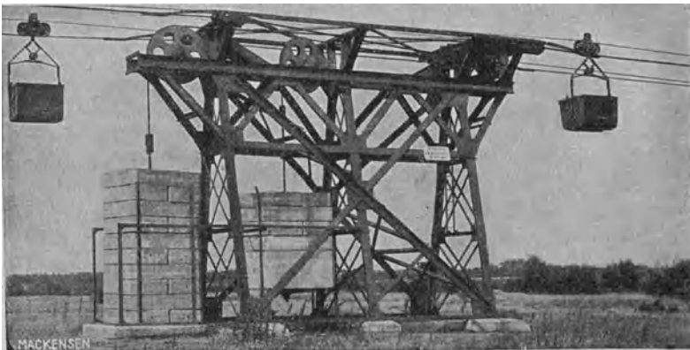
Abb. 90 Tragseil-Verankerung und -Spannstation in Eisen (Mackensen).
