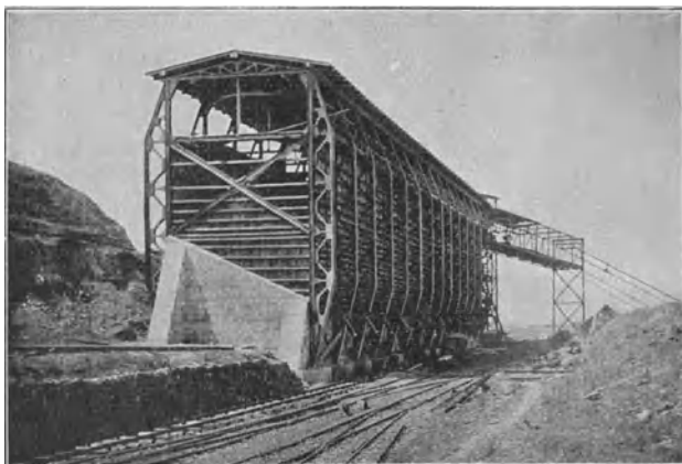
Abb. 334. Füllrumpfanlage der Endstation Gallarta.
