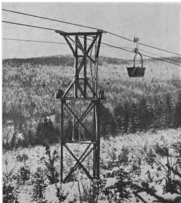
Abb. 73. Aus Einzelteilen zusammengesetzte Eisenstütze (Pohlig).
