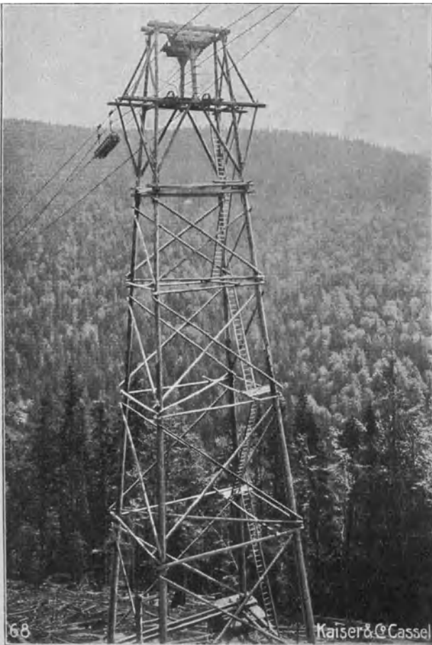
Abb. 68. Umbaute Doppel- stütze von 40 m Höhe.
