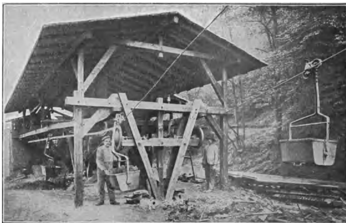
Abb. 496. Beladestation einer Einseilbahn.
