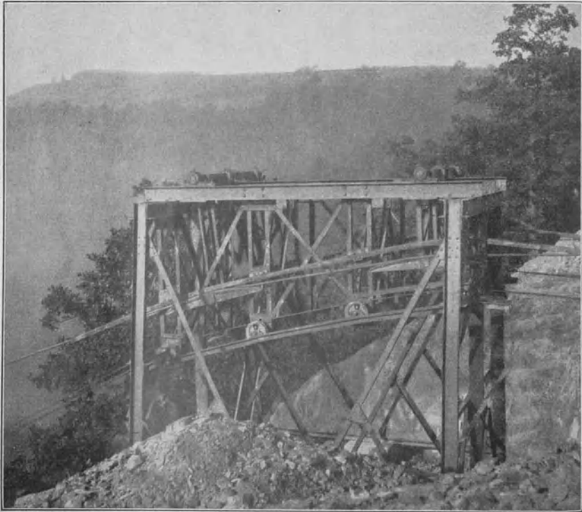
Abb. 109. Übergangsstation an einem Bruchpunkt.
