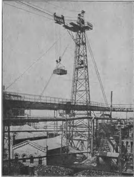
Abb. 580. Fester Turm des Kabelkrans auf Zeche Rheinbaben.
