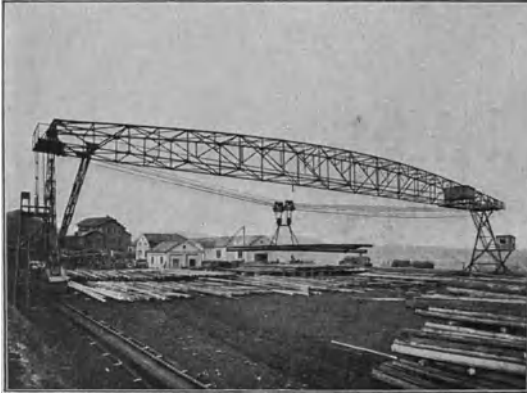
Abb. 615. Kabelkran mit wagerechter Absteifung (Bleichert).
