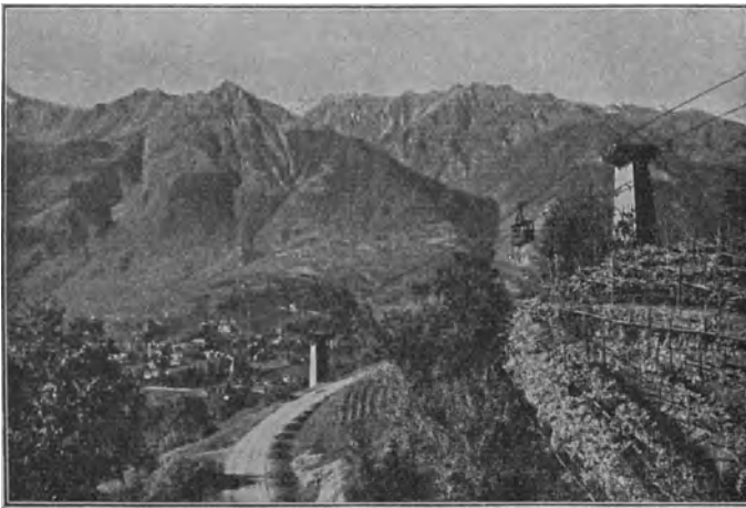
Abb. 550. Streckenbild der Bahn Meran-Hafling (Bleichert).
