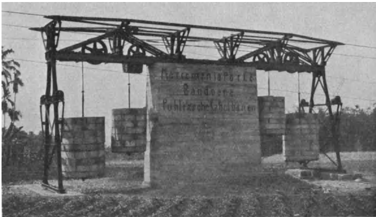
Abb. 87. Doppelte Tragseilspannvorrichtung (Pohlig).
