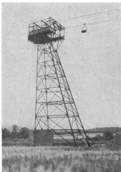
Abb. 383. Umföhrungsstation einer Haldenseilbahn.
