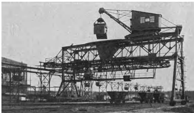
Abb. 438. Absturz- und Aufnahmebrücke in Golpa (Pohlig).
