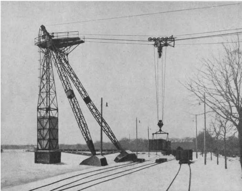
Abb. 575. Pendelstütze und Aufnahme der Last (Pohlig).
