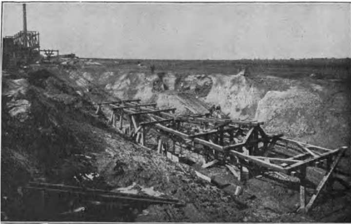
Abb. 313. Beladestation der Drahtseilbahn in Liebertwolkwitz (Bleichert).
