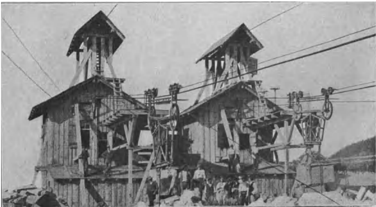
Abb. 567. Endgerüste eines Doppelbaukrans.
