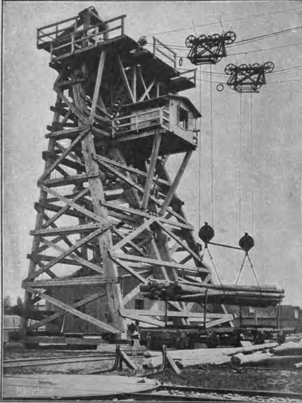
Abb. 568. Maschinenturm eines Doppelkrans.
