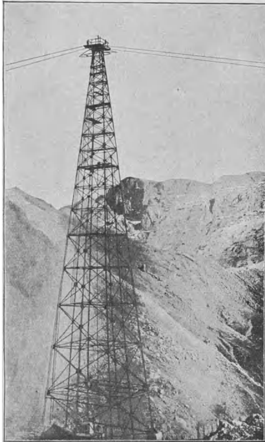
Abb. 79. Stütze von 55 m Höhe (Bleichert).
