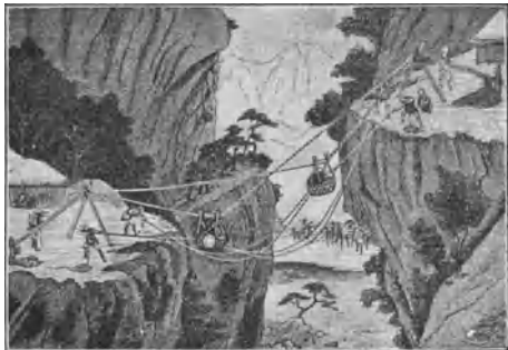
Abb. 4. Alte japanische Seilbahn mit Zugseilen.
