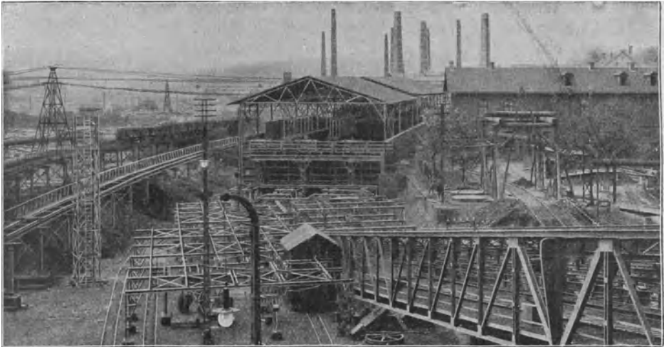
Abb. 378. Blick auf die Füllrumpfe und Aufstellgleise in Neunkirchen.
