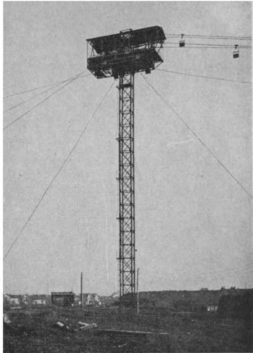
Abb. 404. Mittelstütze der Haldenbahn bei Gießen (Heckel).
