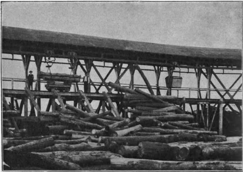
Abb. 297. Entladestation einer Rundholztransportbahn (Bleichert).
