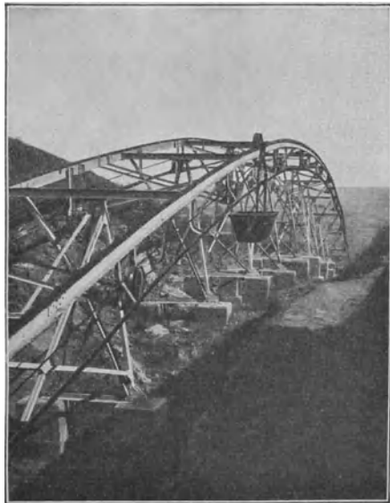
Abb. 108. Bergübergang mit Schienenstrecke (Bleichert).
