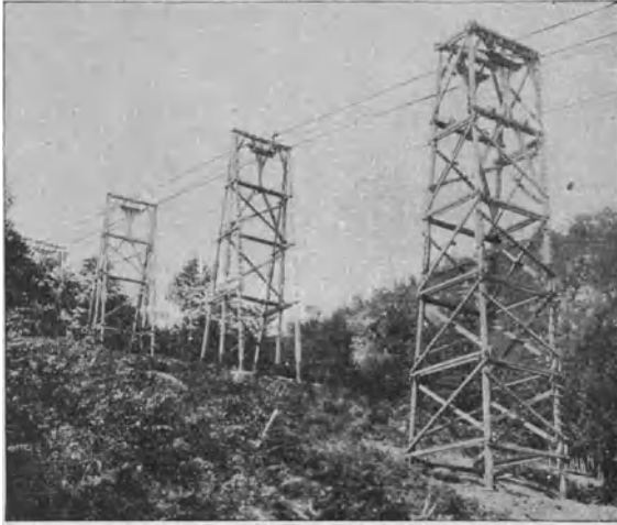
Abb. 67. Bahn mit Doppel- stütze (Bleichert).
