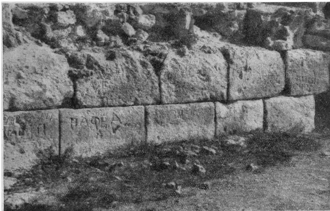
Рис. 10. Херсонес. Кладка западной крепостной стены. 1-я куртина VI в.
