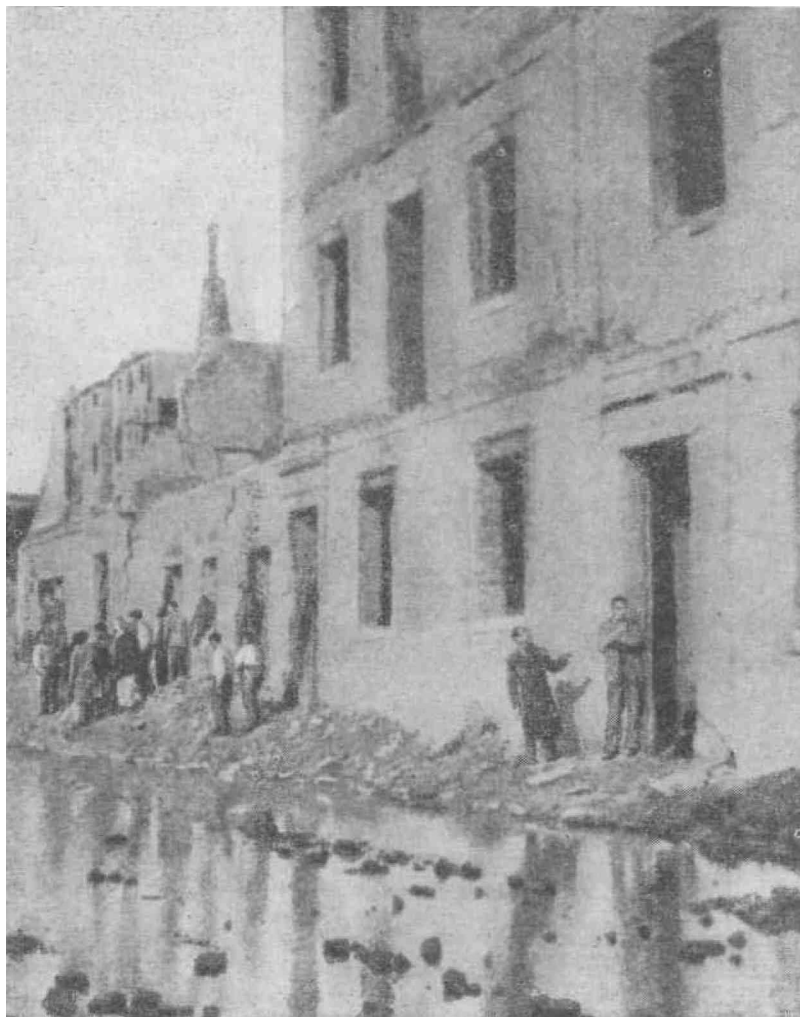
Разрушения на улице Абади в Порт-Саиде.
