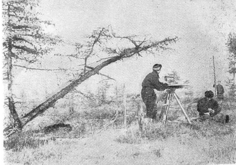
На будущей строительной площадке
