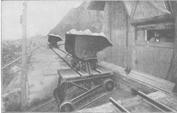
Abb. 216. Obere Station einer Bremsbergförderung mit Gestellwagen (Bleichert).
