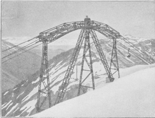
Abb. 422. Schienenübergang (Bleichert).
