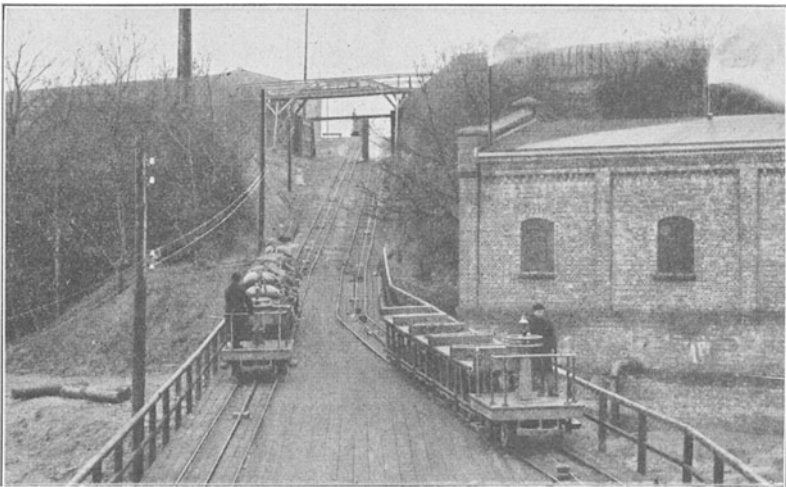
Abb. 282. Unterseilförderung mit Greiferwagen (Bleichert).
