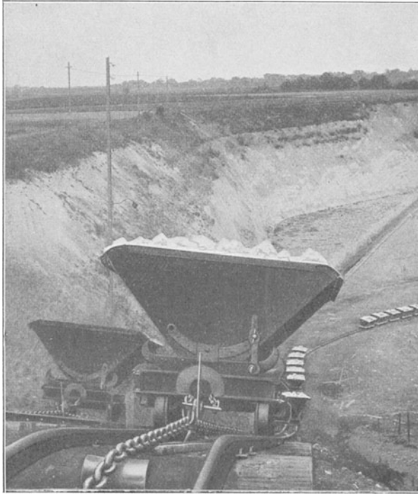
Abb. 257. Unterkettenkuppler (Bleichert).
