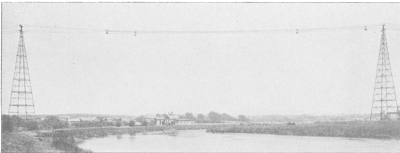
Abb. 555. Überqueren eines von Seeschiffen befahrenen Wasserlaufes durch Drahtseilbahn (Bleichert).
