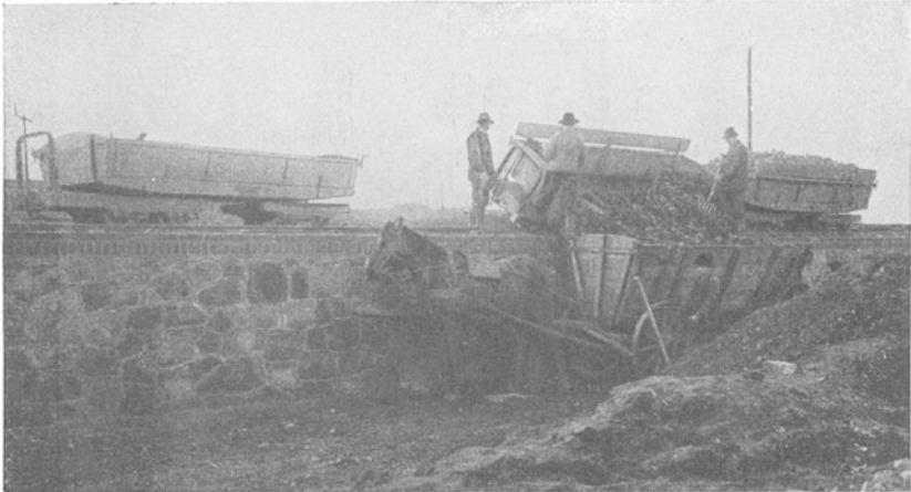
Abb. 8. Entladen der Rüben aus einem Feldbahnwagen mittels Kippvorrichtung in Landwagen.
