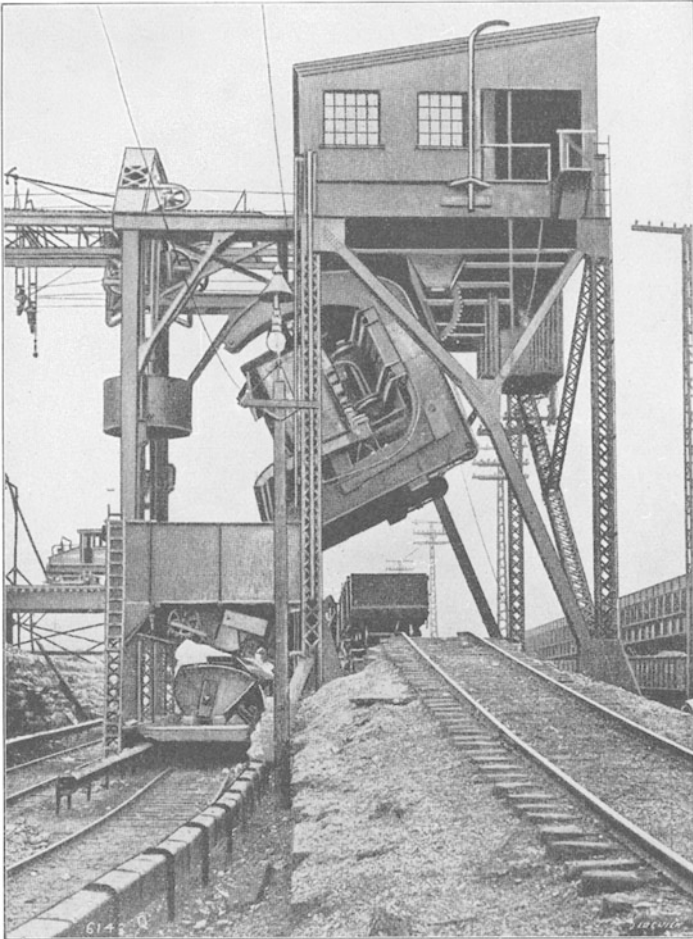
Abb. 206. Hochwipper mit Zwischenbehälter.
