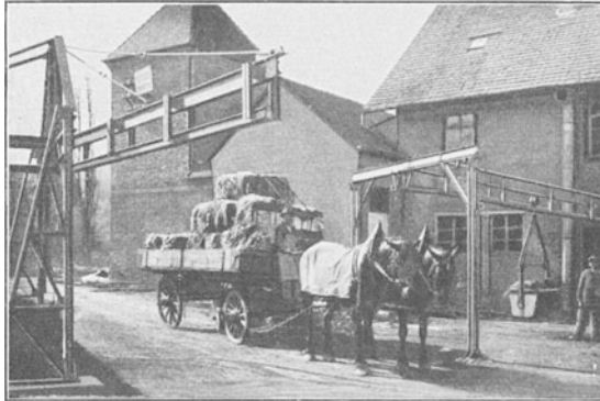
Abb. 381. Ausschwenkbares Schienenstück (Kaiser).
