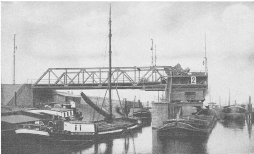
Abb. 140. Schwerkraftkipper für wechselnde Wasserstände.
