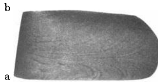
Fig. 15. b a: Umfang eines gestoßenen Loches im Flansch eines Flußeisenträgers (vgl. Fig. 16).
