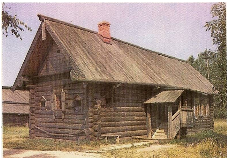
Водяная мельница. XIX (из села Нюрюг). КИАМЗ Watermill from the village of Niuriug. 19th century Дом Лоховой. 1873 (из деревни Вашикино). КИАМЗ The Lokhova House from the village of Vashkino. 1873
