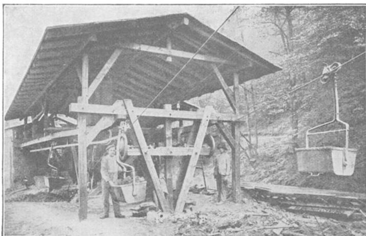
Fig. 240. Beladestation einer Einseilbahn. Bleichert.
