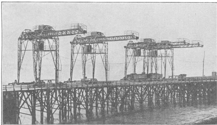
Fig. 394. Bleichertsche Krane mit verschiebbarer Fahrbahn.
