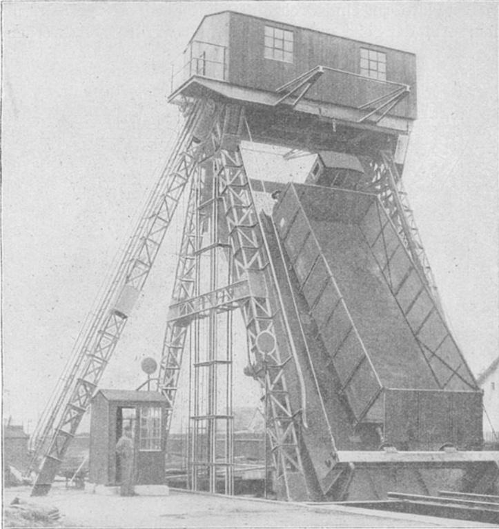
Fig. 84. Doppelkipper von Bleichert.
