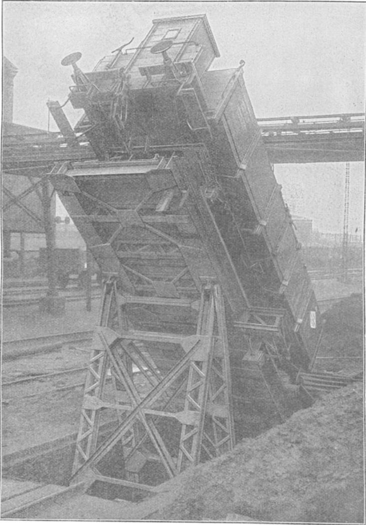
Fig. 81. Niveauekipper mit Kniehebelantrieb. Maschinenfabrik Augsburg-Nürnberg.
