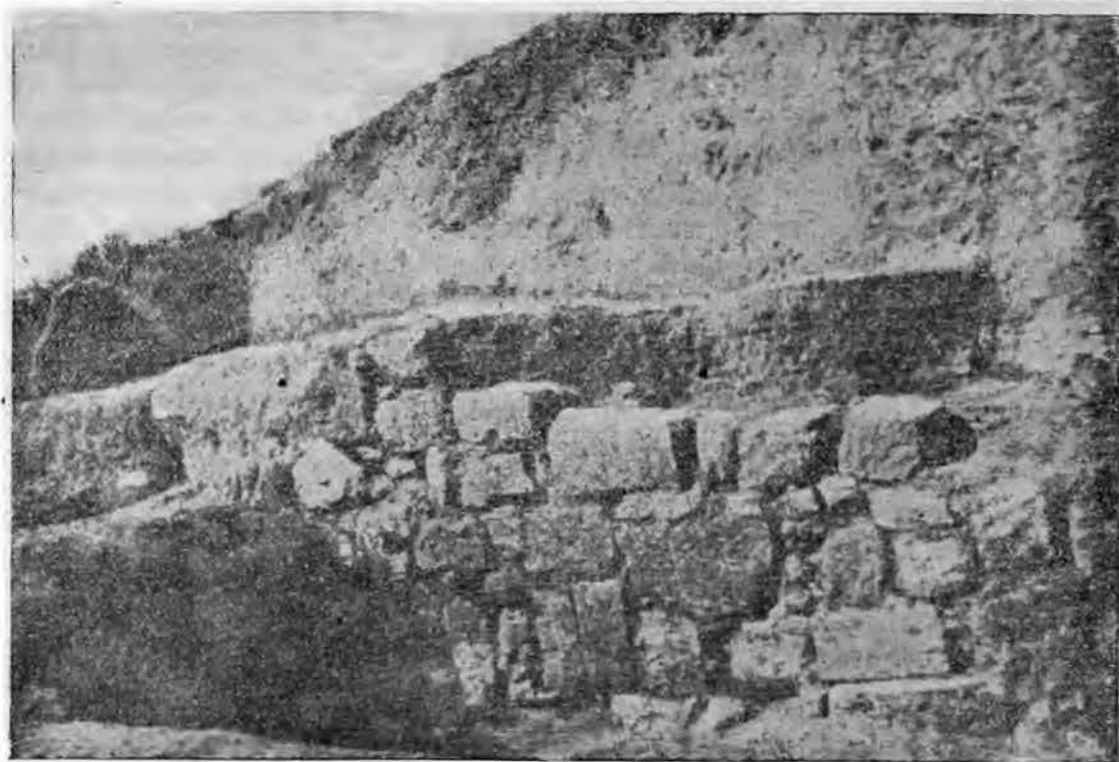
Рис. 30. Пантикапей. Раскоп 1943 г. Подпорная стена
