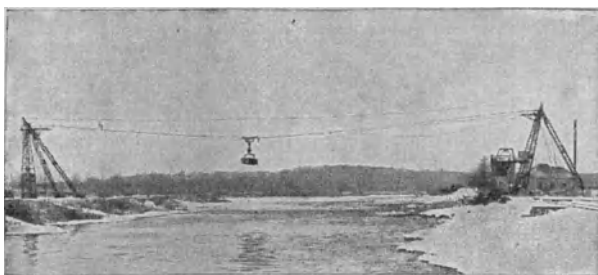
Abb. 40. Kabelkrananlage der Firma Pohlig (Köln).
