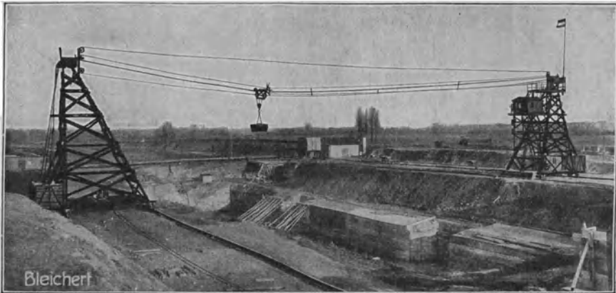
Abb. 38. Kabelkrananlage beim Bau einer Schleuse am Mittellandkanal in Minden (Bleichert).
