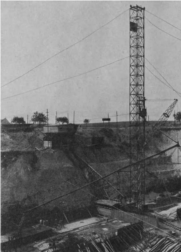
Abb. 15. 750-l-Giebturmanlage beim Bau der Schleuse Anderten. (Lieferant: Lincke-Hofmann-Lauchhammer A.G. Berlin.)
