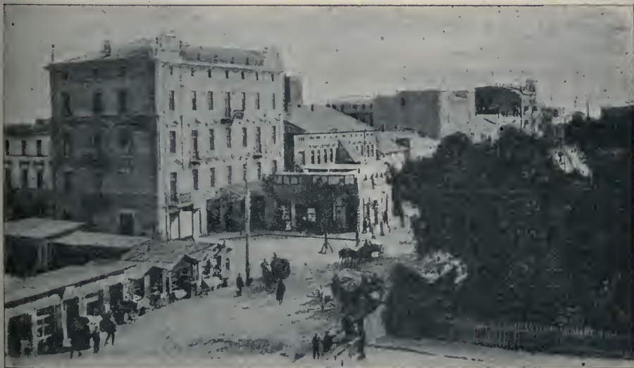
Sosnowice. Ulica kolejowa.
